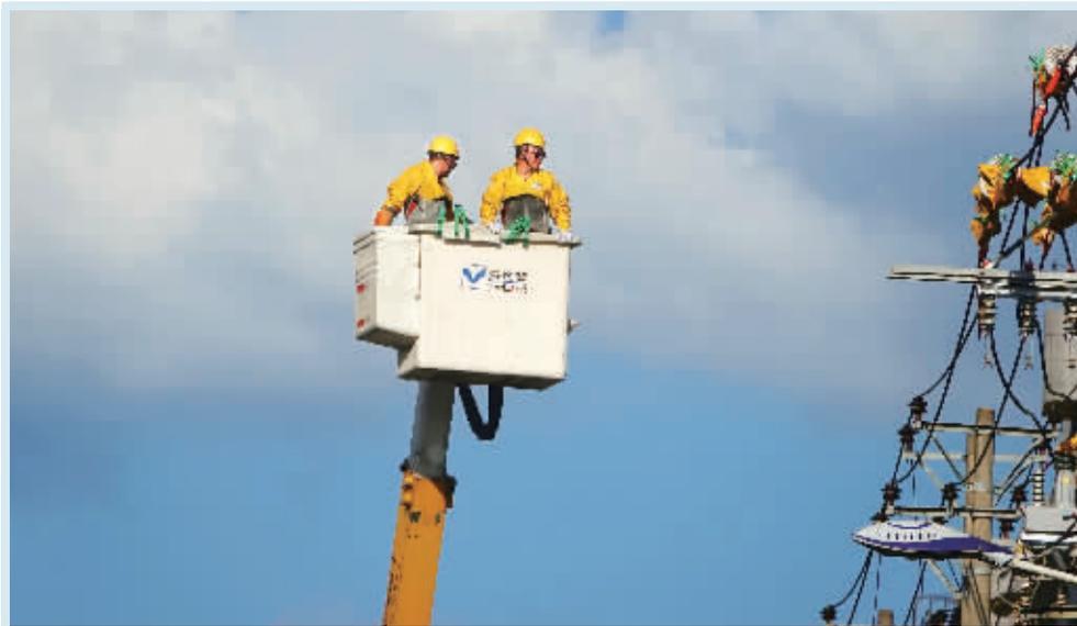
7月23日,龙山县城朝阳路,国网龙山县供电公司带电作业人员冒着高温带电处理10千伏宝朝线开关缺陷,确保电网安全稳定运行,客户清凉度夏。田良东 摄
