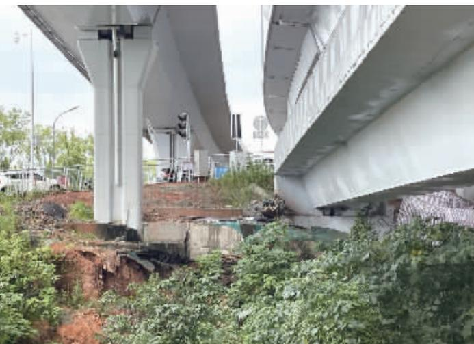
▲一桥墩处,排水管空中排水,地上有明显塌陷迹象。 杨洁规 摄
