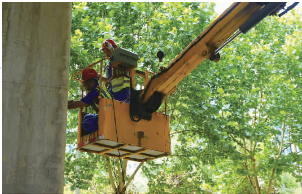
桥梁养护员正在高空作业。
