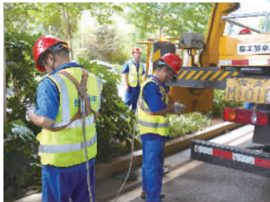
桥梁养护员正在穿戴防护工具。
