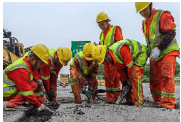
7月9日中午，京港澳高速公路长沙段，养护工人正在进行路面中修作业。 通讯员 供图
