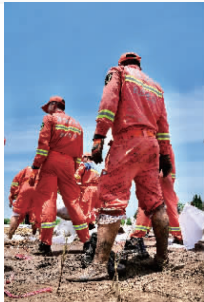
7月8日，岳阳君山区钱团垸堤处险现场。
