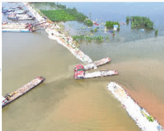
7月8日17时,大堤已封堵180.5米,剩余45.5米。
