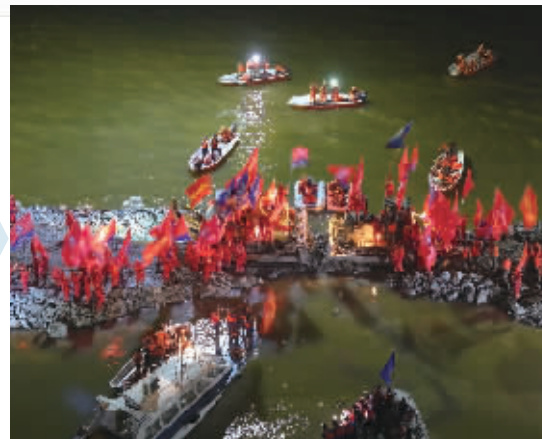
7月8日22时33分,团洲垸洞庭湖大堤决口完成封堵。
