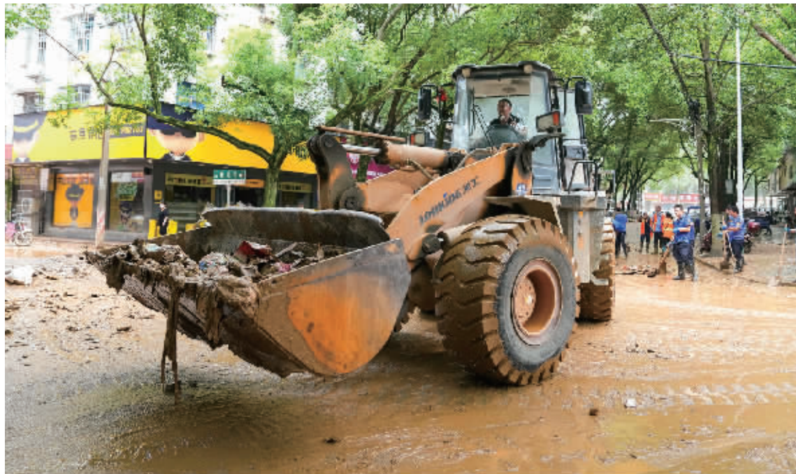
7月3日，在平江县商北街，铲车在疏通道路。
