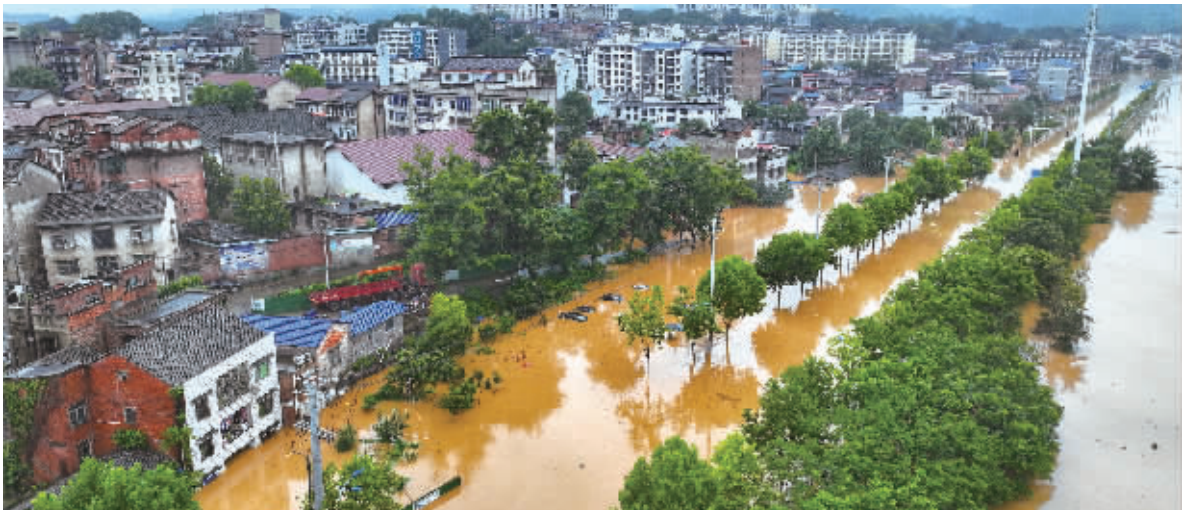
7月1日15时，平江县百福隧道入城积水较深，车辆、行人均无法正常通行，公安部门已在现场拉起警戒线。 顾荣 摄
