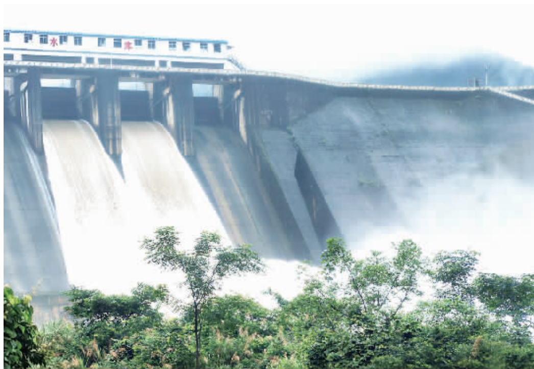
6月18日，江永县源口水库开闸泄洪。近日，受持续强降雨天气影响，江永县源口水库水位上涨，为减轻上下游防洪压力，水库及时开闸泄洪，确保水库及流域内人民生产生活安全。 田如瑞 周多昊 摄
