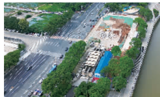
湘江大道沿线排水等管线改造工程二期项目位于长沙市开福区、天心区沿湘江大道范围内。
