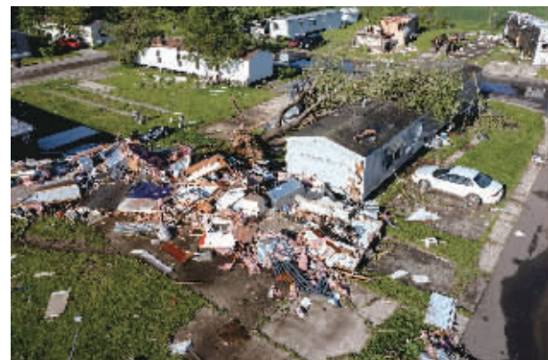
这是5月8日在美国密歇根州卡拉马祖拍摄的遭龙卷风损毁的房屋。
