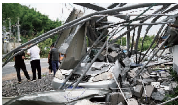
4月28日,在遭受龙卷风袭击的广州市白云区钟落潭镇光明村,车辆被倒塌的建筑物结构掩埋。
