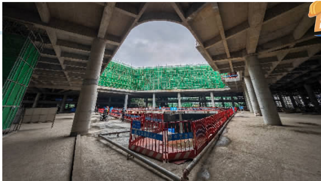
4月23日，长沙机场改扩建工程综合交通枢纽主体结构完工。 湖南日报全媒体记者 辜鹏博 摄
