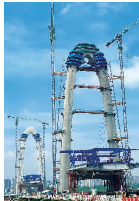
长沙兴联路大通道项目施工现场航拍图。朱帅铭 摄
