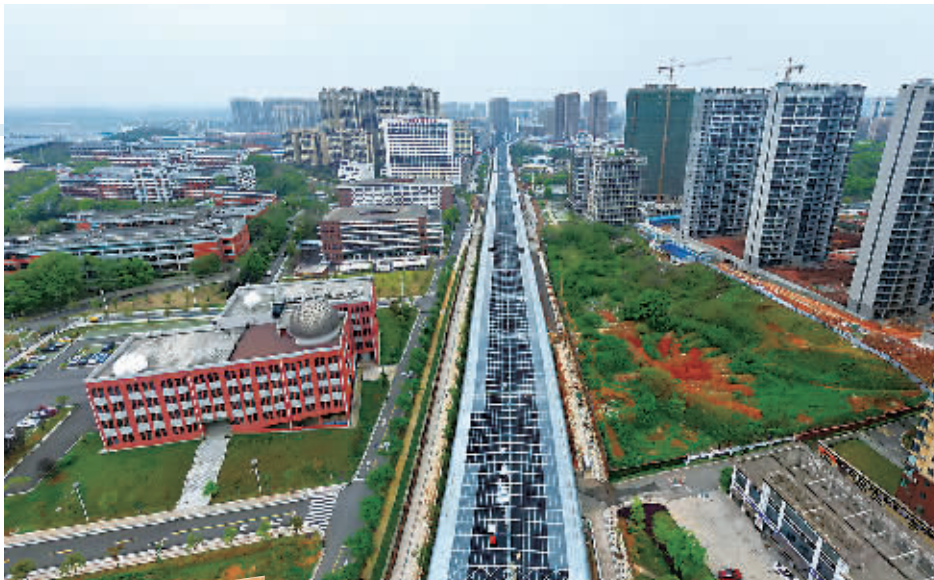
万家丽快速化改造北延线项目将于4月30日试通车,6月底完成建设。图为施工现场。 朱帅铭 摄
