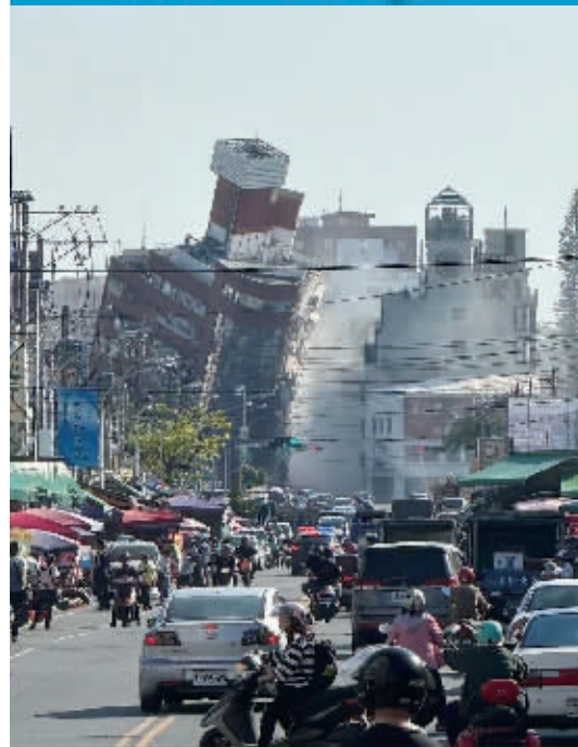
强震发生时，花莲县北滨街一栋公寓民宅大幅度倾斜。 新华社图
