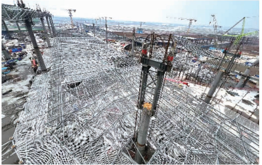
2月29日，长沙机场T3航站楼项目，F大厅中间层钢网架提升现场。 通讯员 供图
