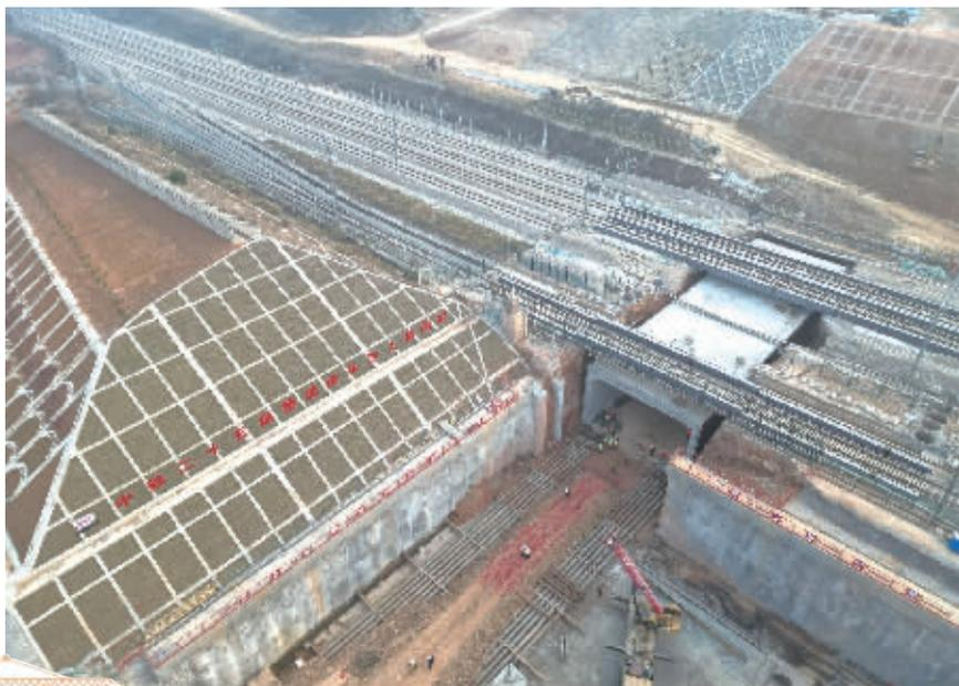
12月28日，金岭路下穿长株潭城际铁路立交工程，顺利完成了长沙侧框架顶进施工，标志着金岭路项目顶进工程施工完成过半，这也是全国首例长顶程下穿高速铁路的立交工程。
