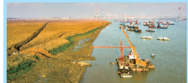
国网湖南电动汽车服务有限公司在进行岳阳锚地岸电10千伏海缆敷设
