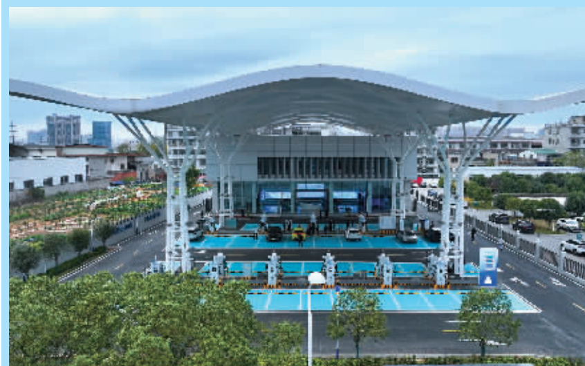
长沙县梨梨光储示范充电站验收现场
