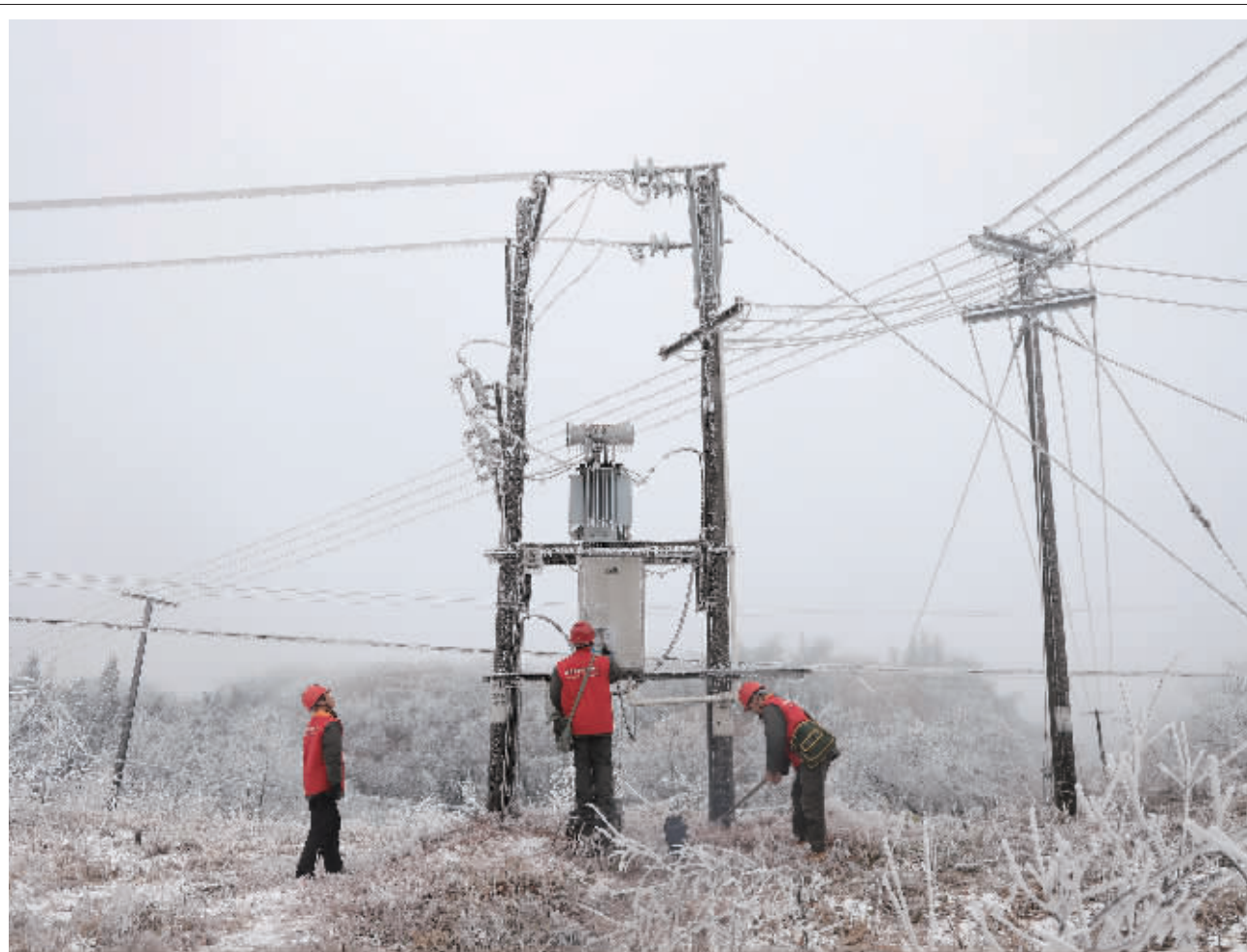
12月16日,国网常德供电公司壶瓶山供电所东方红(电骡子)共产党员服务队队员对10千伏果峰线北山支线进行巡视,检查防冰拉线,清理通道树竹。
