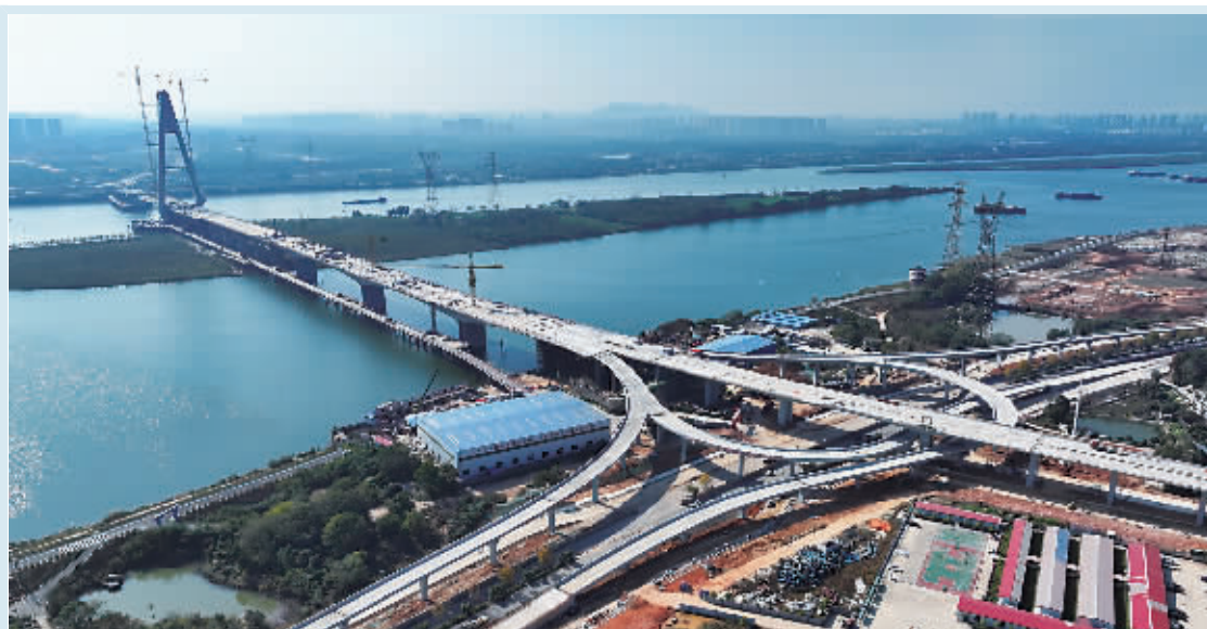
12月1日，长沙市望城区香炉洲大桥项目施工现场，主桥桥面吊装作业正在有序进行中。该桥是湘江首座按照Ⅰ级航道标准建设的桥梁，主塔由中交二航局承建，高202米，采用“湘江之钻”造型设计，主跨300米，是湘江上跨度最大、主塔最高的独塔斜拉桥。 湖南日报全媒体记者 童迪 摄
