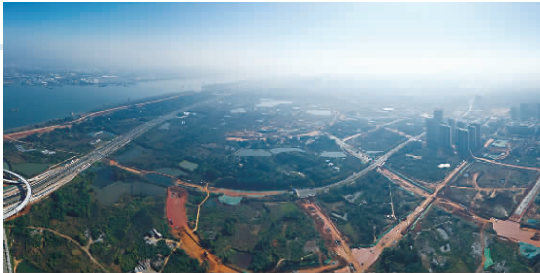
大泽湖·海归小镇地热能开发利用项目的施工现场航拍图。朱帅铭 摄
