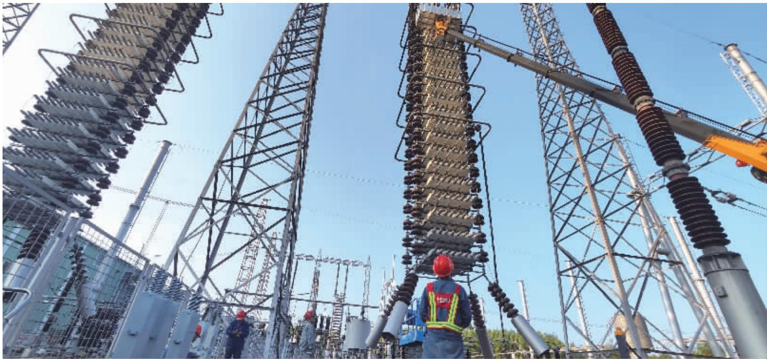
在±500千伏鹅城换流站控保改造及年度检修现场,工作人员正在开展直流场滤波设备检修。
