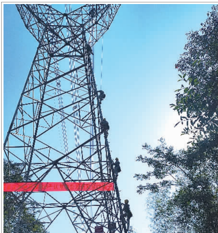
日前，国网湖南超高压输电公司带电作业中心在位于湖南益阳的500千伏益艾线069号(紧凑型)铁塔开展带电更换B相(中相)右串复合绝缘子作业，此次500千伏紧凑型线路上实施更换绝缘子作业在国内尚属首例，填补了国内该项技术领域空白。 ■摄影/刘辉军
