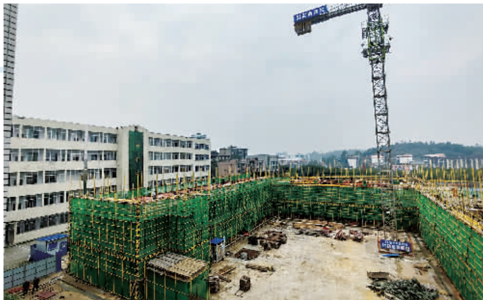
11月23日,中方县一中施工现场。
