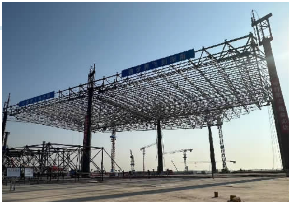
11月1日，长沙机场改扩建工程T3航站楼首区屋面钢网架正式封顶。
