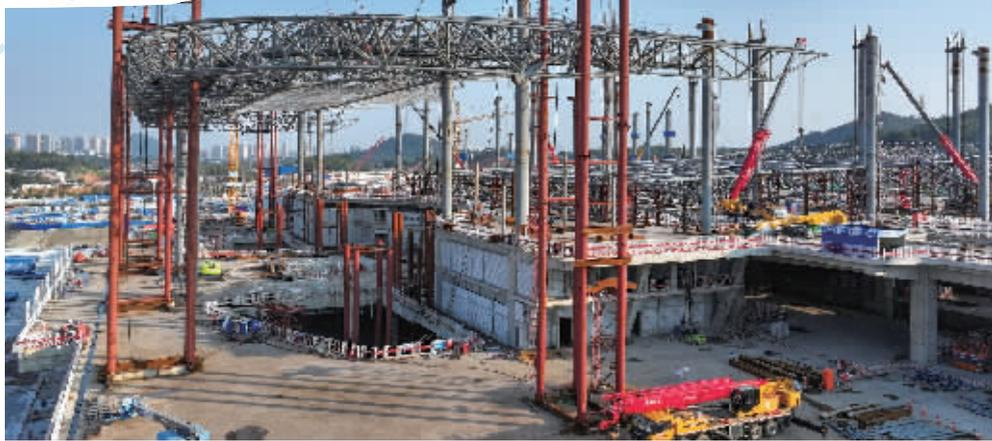
长沙西站北站房钢结构屋盖提升施工现场。湖南日报全媒体记者 郭立亮 摄
