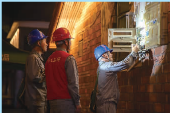
国网郴州供电公司员工在“711”矿核查新增用户线路设备情况。
