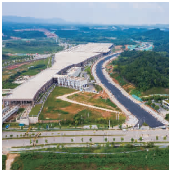
梅溪湖国际新城二期龙柏路项目建设现场。通讯员 供图
