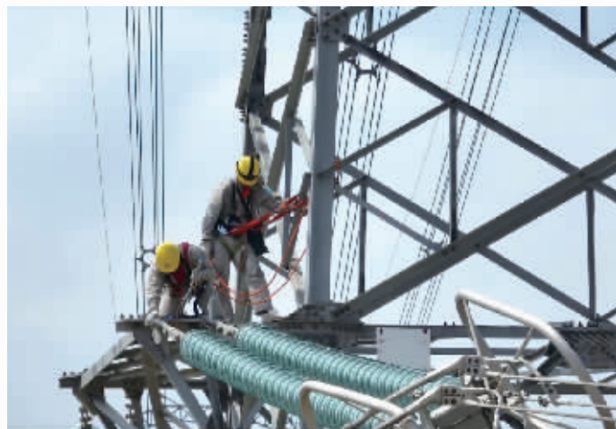
7月11日，500kV潇星Ⅰ线长沙县区段，国网湖南超高压输电公司带电作业中心工作人员在处理铁塔端隐患。 通讯员 供图
