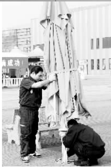
11月1日,两名工人在世博园里拆除遮阳伞。
