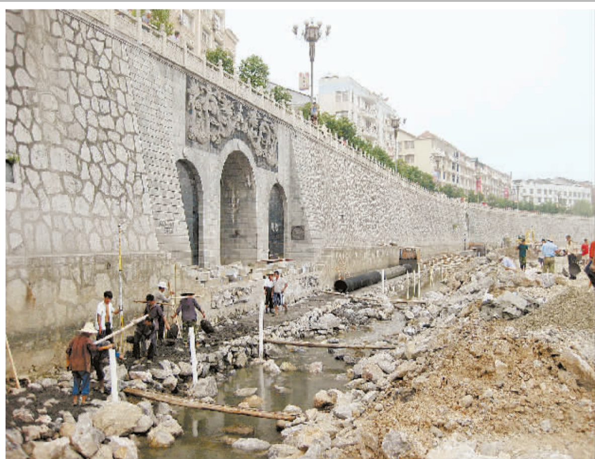
8月4日,淑浦县城防洪大堤,施工人员在紧张地砌筑污水处理管网挡墙。为有效降低城市生活生产污水对淑水河水质的破坏,该县大力推进污水处理工程建设。目前,管网建设基本完成,预计今年10月份建成投入运行使用。 周生齐 武清华 摄
