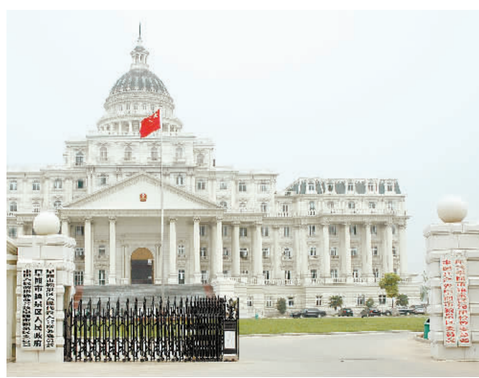
图为张治安当年占用耕地修建的豪华办公楼（2008年6月27日摄）。
