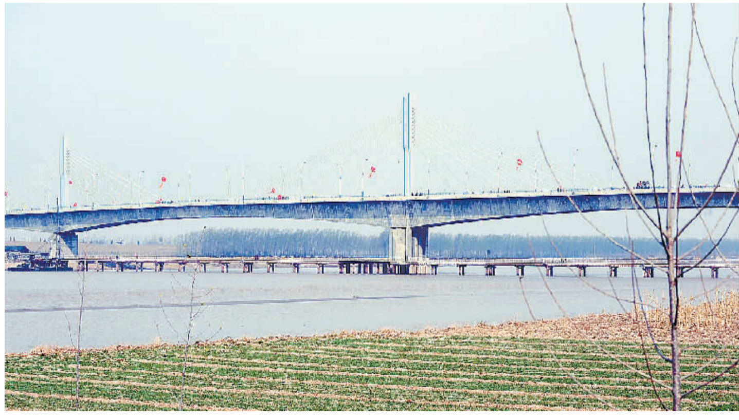
11月26日，我国首座四塔单索斜拉桥——山东济阳黄河公路大桥建成通车。大桥总投资4.2亿元，全长1165米，设计为双向4车道，桥面宽21米，主桥最大跨度216米。大桥建成后，成为沟通京沪高速、青银高速等多条国家公路主干线的重要枢纽。新华社发
