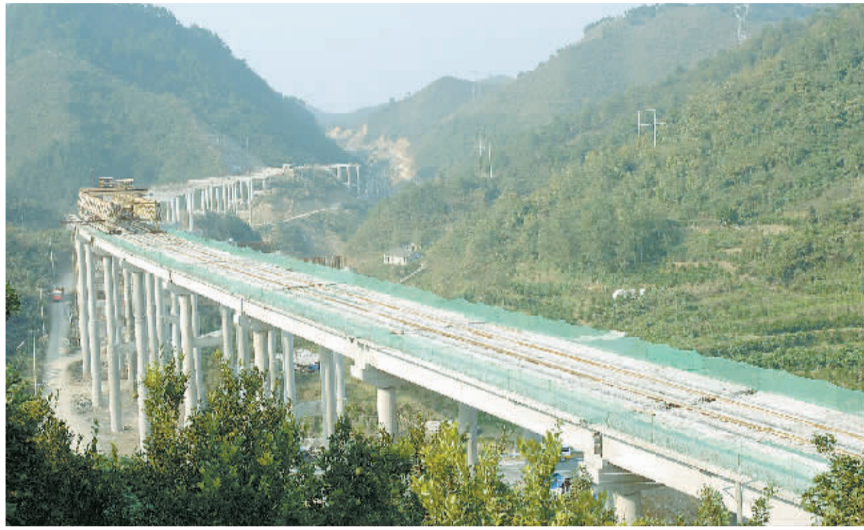
11月10日,穿越高山峡谷的吉茶高速公路高架桥正在进行桥面施工。主线全长65公里的吉首至茶洞高速是国家高速公路重点规划的8条西部公路大通道之一——长沙至重庆公路中的一段,也是省规划的“五纵七横”高速公路网的重要组成部分,预计2011年建成通车。 本报记者 徐行 李伟锋 摄
