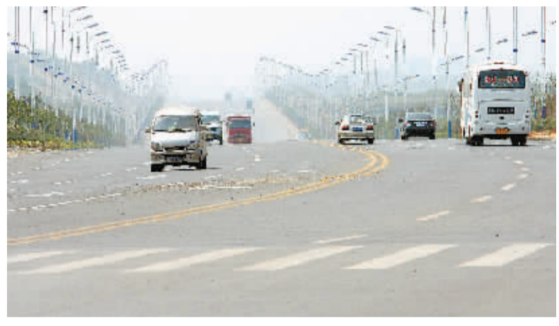
邵阳大道近日建成通车。邵阳市大规模建设城市基础设施,近两年每年投资都在7亿元以上。 本报记者 张京明 摄
