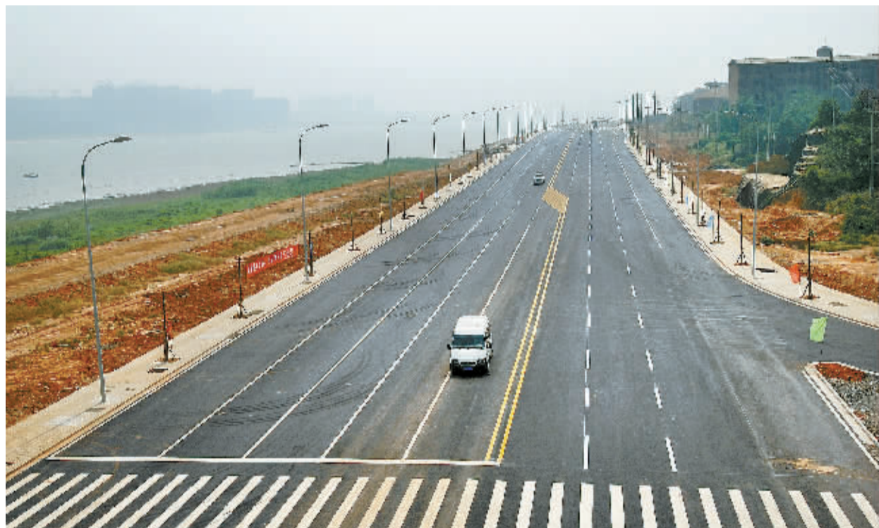
图为中建五局建设中的长沙市潇湘大道北段工程项目。
