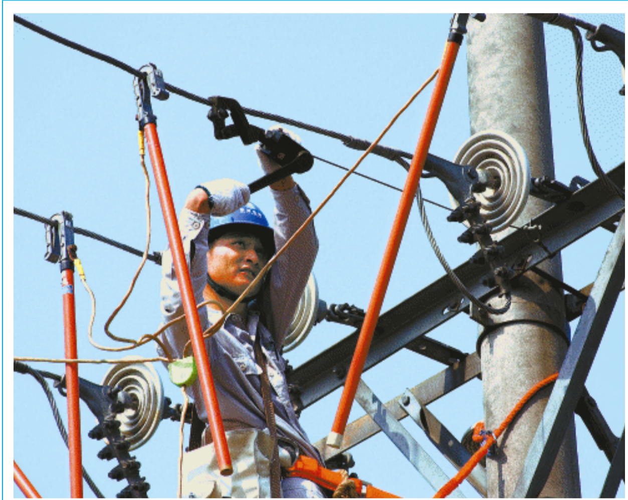
9月8日,益阳市资阳区供电局外线班工人正在资阳大道电杆上精心更换导线绝缘子。为缓解用电紧张状况,该供电局近段组织一线职工,共抢修各类供电故障100多起,故障修复率达100%。 田小平 摄
