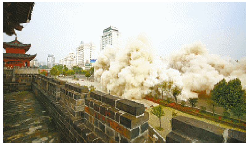
9月5日下午,岳阳市在南岳岭一带进行定向爆破,启动沿湖风光带第三期工程的拆迁建设。 范向辉 摄
