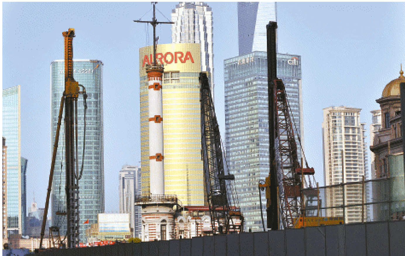
正在建设中的上海外滩地下通道一角（8月26日摄）。
