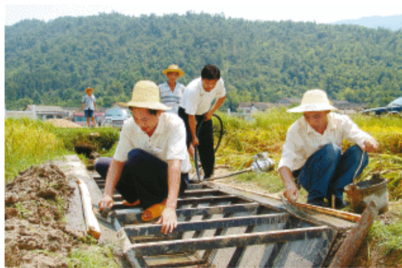
连日来,汨罗市农业综合开发技术人员在川山坪镇新建排水灌渠。今年,该市水渠建设采用钢模现浇工艺施工,提高工程的密实度,预计工程使用寿命增加10年左右。 黄松柏 摄
