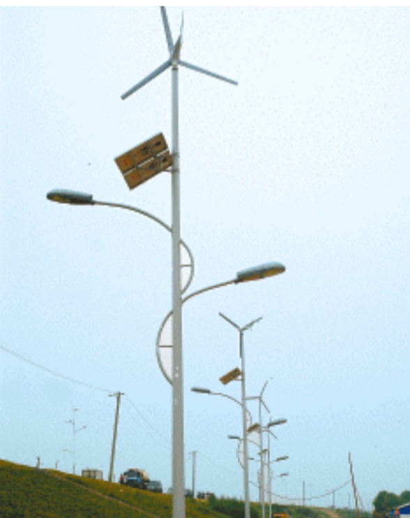
8月25日,长沙市开福区五合滨江水道上新安装的风光互补景观灯,正利用风力发电。这45盏风光互补景观灯与普通路灯外观有所不同,顶部配备有风叶发电机和太阳能板,分别可以利用风能和太阳能发电,并根据天空亮度自动开启,既美观又节能。 本报记者 徐行 摄
