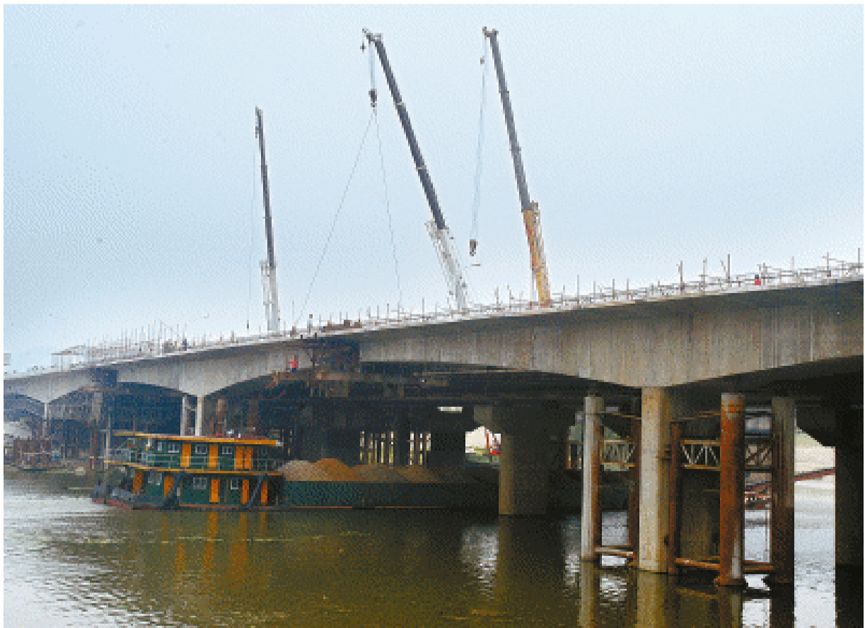
8月26日,长沙市芙蓉北路捞刀河大桥拓改工程进入最后的辅桥桥面施工收尾阶段。捞刀河大桥由主桥、东西辅桥三部分组成,其中主桥宽24米,东西辅桥各宽9米,计划本月31日实现辅桥竣工通车,届时将进一步缓解芙蓉北路交通压力。 本报记者 徐行 摄
