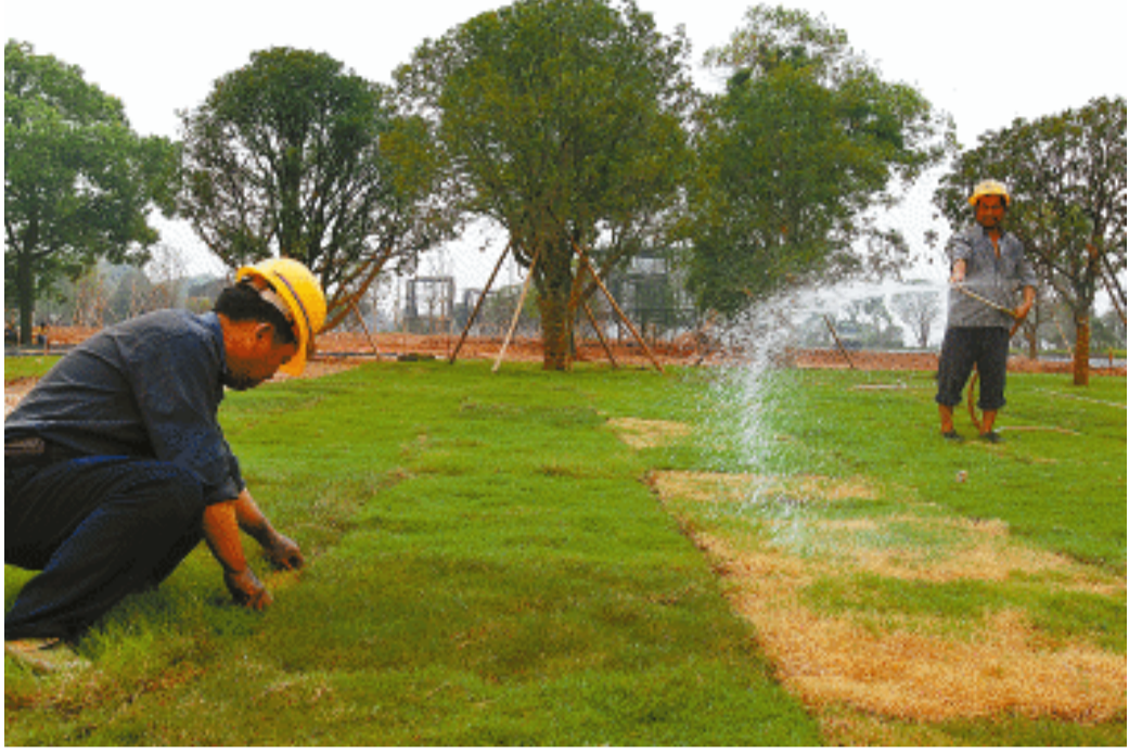
8月25日,长沙市橘子洲文化公园,施工人员进行施工。目前,橘子洲景区各项建设正在紧锣密鼓地进行,可望于9月1日起免费对市民开放。本报记者 郭立亮 摄
