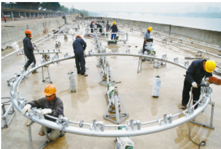
8月18日,长沙市橘子洲焰火广场音乐喷泉进入设备安装阶段。该喷泉池长达300米,用水泵361台,有LED水下彩灯4586盏和大型音响设备,并采用多媒体操作。 本报记者 徐行 摄
