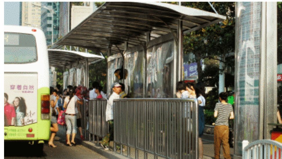
长沙市创建全国文明城市工作进入冲刺阶段。长沙市五一大道等主要道路上的港湾式公交站台,历时1个多月的改造施工全部完工投入使用。新公交站台不仅能更好的遮阳挡雨,而且美观大方,提升了城市品位。 本报记者 郭立亮 摄
