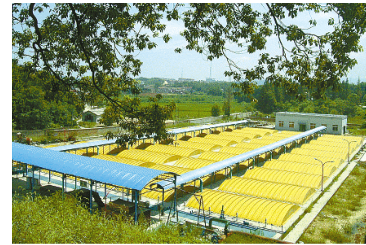
近日,中石化巴陵石化供排水事业部的污水处理装置中池经过一系列整改后,完成了整池加盖防臭工程,改善了周边空气质量。金黄色、呈弧形的池盖,和周边的绿色植被相互衬托,形成一道美丽的风景。 彭展 谭雄峰 摄
