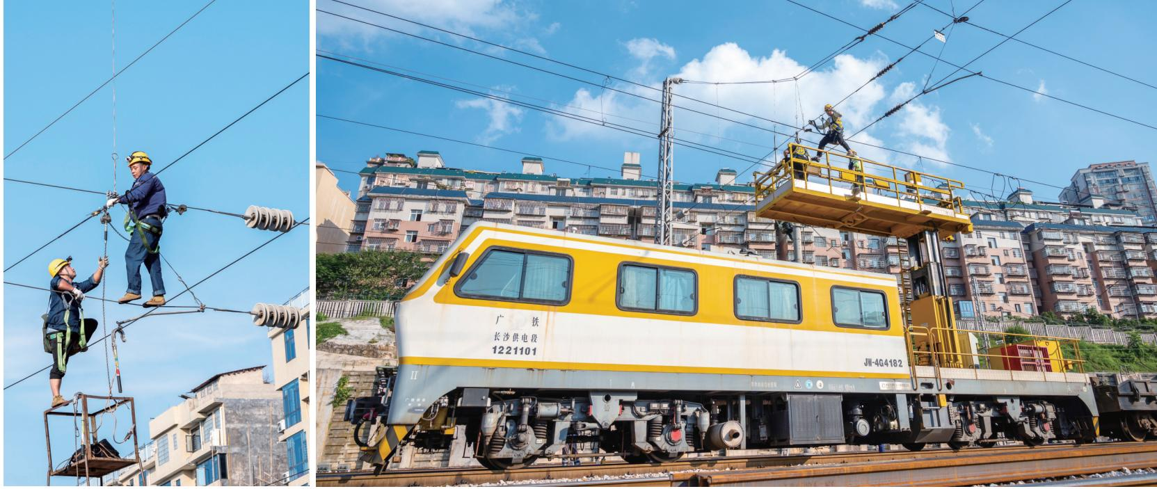
7月31日，广铁集团长沙供电段娄底维修车间对沪昆线娄底枢纽牵引用电设备进行90分钟大规模综合整治。此次作业为枢纽首次全链条施工，重点整治牵引用电设备病害，全力保障高温天气铁路运输安全。
