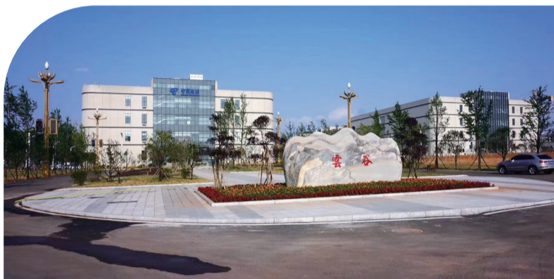
位于长沙望城的中国电信云谷大数据中心。
