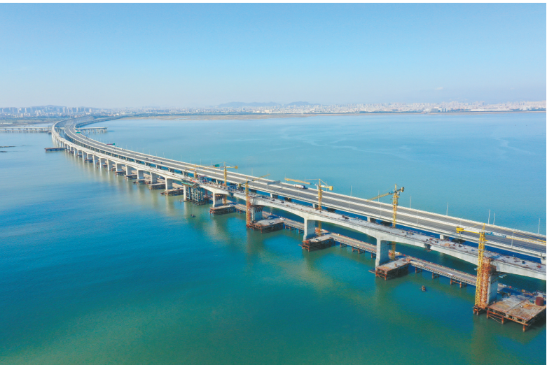
11月30日，中国首条跨海高铁——新建福（州）厦（门）铁路泉州湾跨海大桥全桥贯通，标志着新建福厦铁路建设进入最后冲刺期。泉州湾跨海大桥全长20余公里。 新华社发
