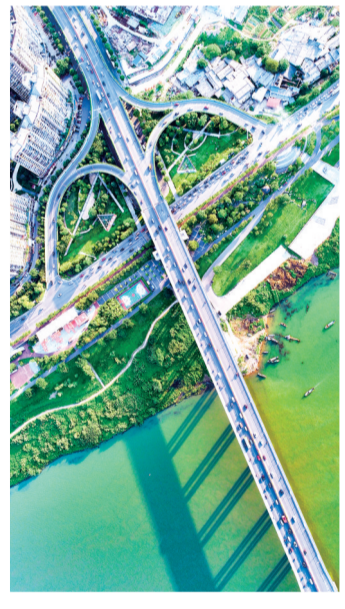
株洲芦淞大桥。王伟 摄
